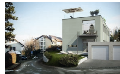
Horgen, Bergwerkstrasse: sale loft apartments
